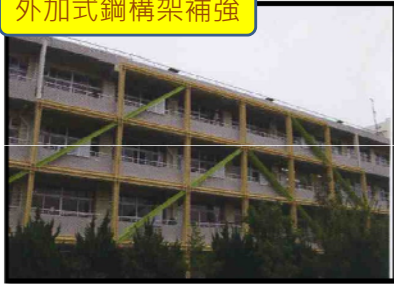
外加式鋼構架補強
